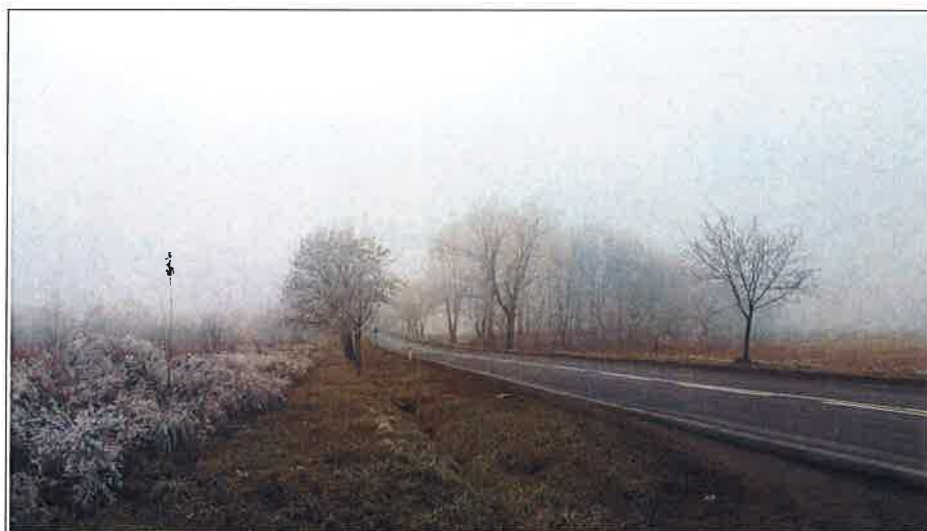
Widok drogi krajowej DK94 w kierunku zachodnim
