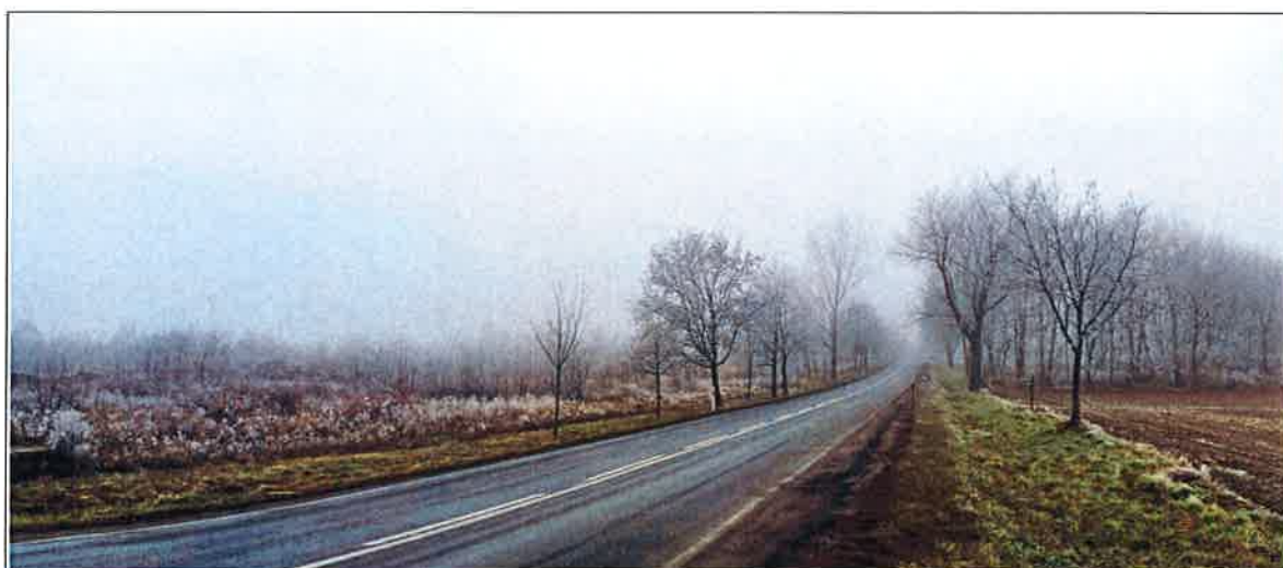
Widok drogi krajowej DK94 w kierunku zachodnim
