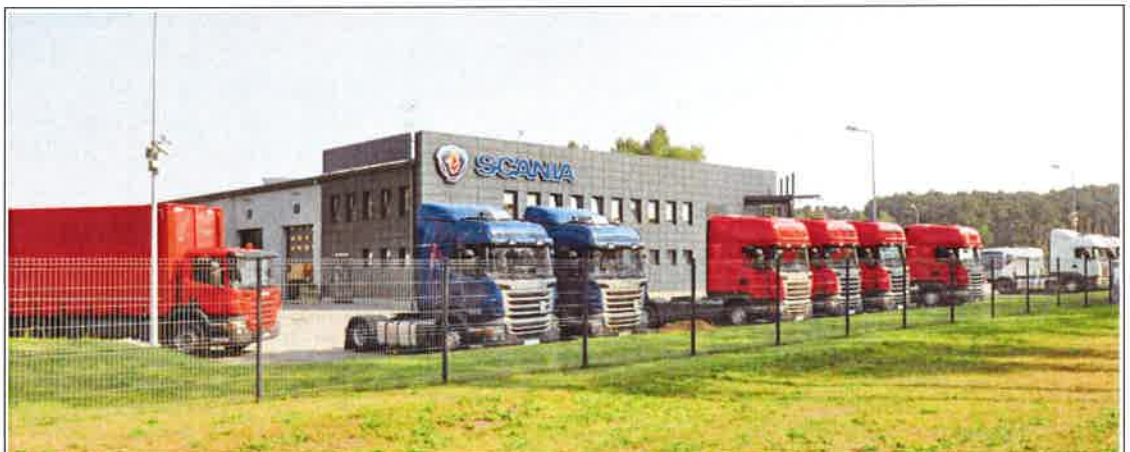
Sąsiedztwo nieruchomości – serwis samochodów ciężarowych Scania
